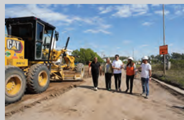
La obra sobre Poretti ya está en marcha.
