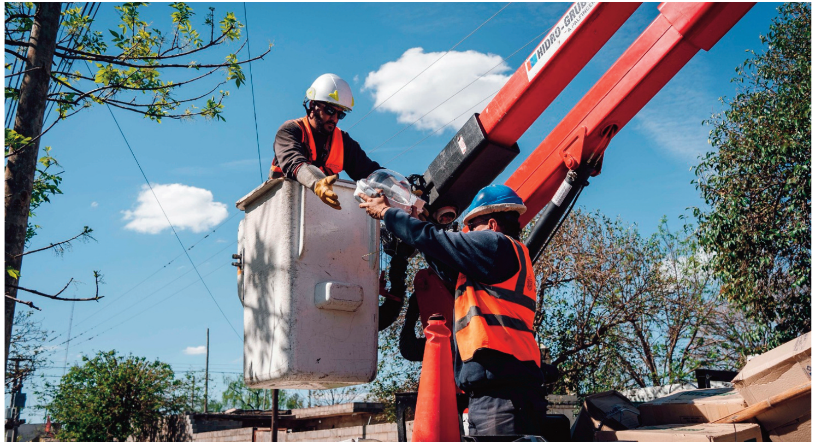
Trabajan en el alumbrado público.
