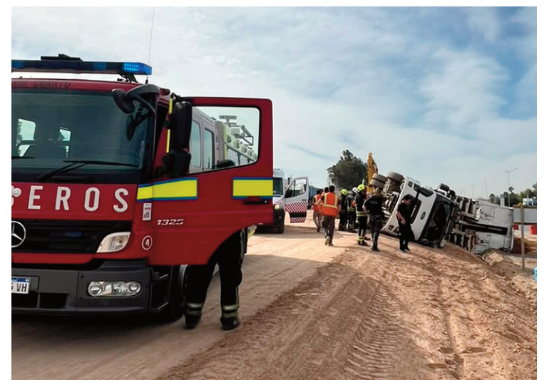
Un camión Ford Cargo con batea, afectado a una de las empresas que realiza la obra de la circunvalación, volcó sobre su lateral izquierdo en ruta A005 y Presidente Perón Oeste, en circunstancias que se tratan de determinar. El transportista de 55 años fue rescatado y trasladado al Hospital San Antonio de Padua, con lesiones menores por el servicio de emergencias médicas. Intervinieron bomberos voluntarios y personal policial.
