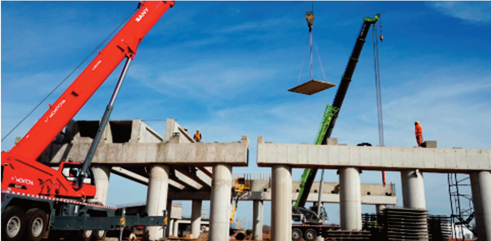
Avanza la obra de la Circunvalación.
