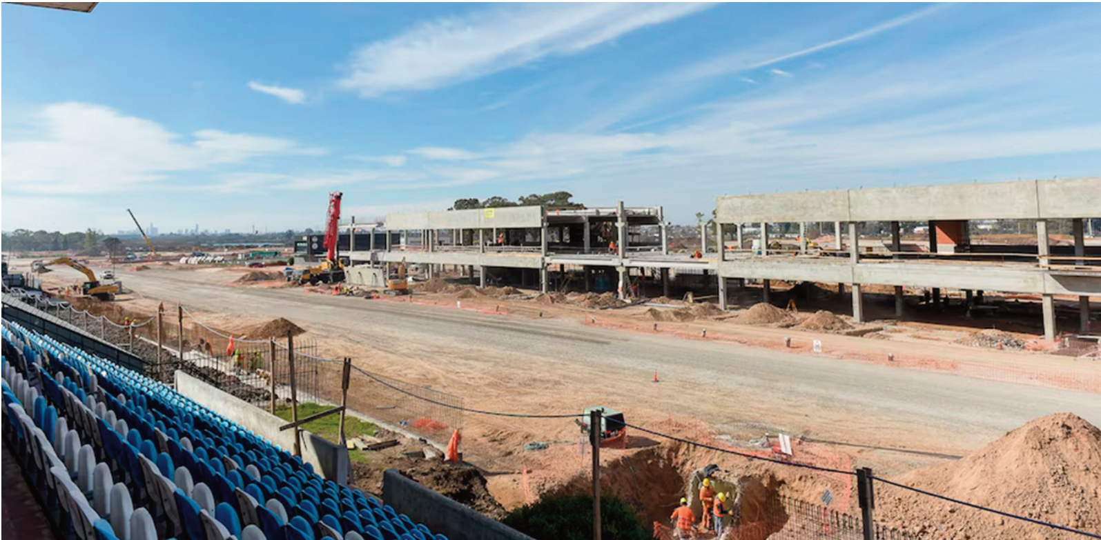
Las obras en el autódromo Oscar y Juan Gálvez que deberán estar listas para el MotoGP en abril de 2027.
