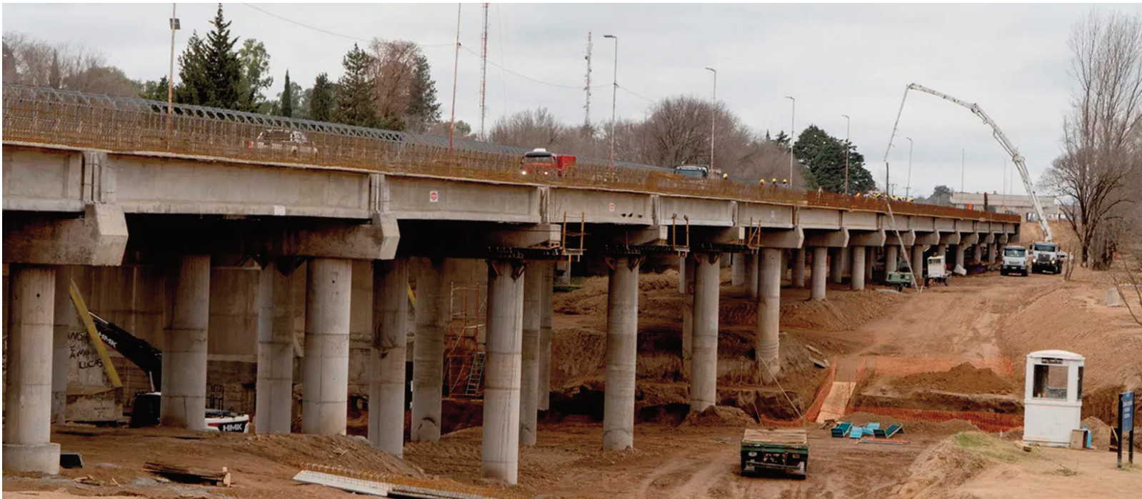
Comienza la obra del Emos en el sector de la Circunvalación.
