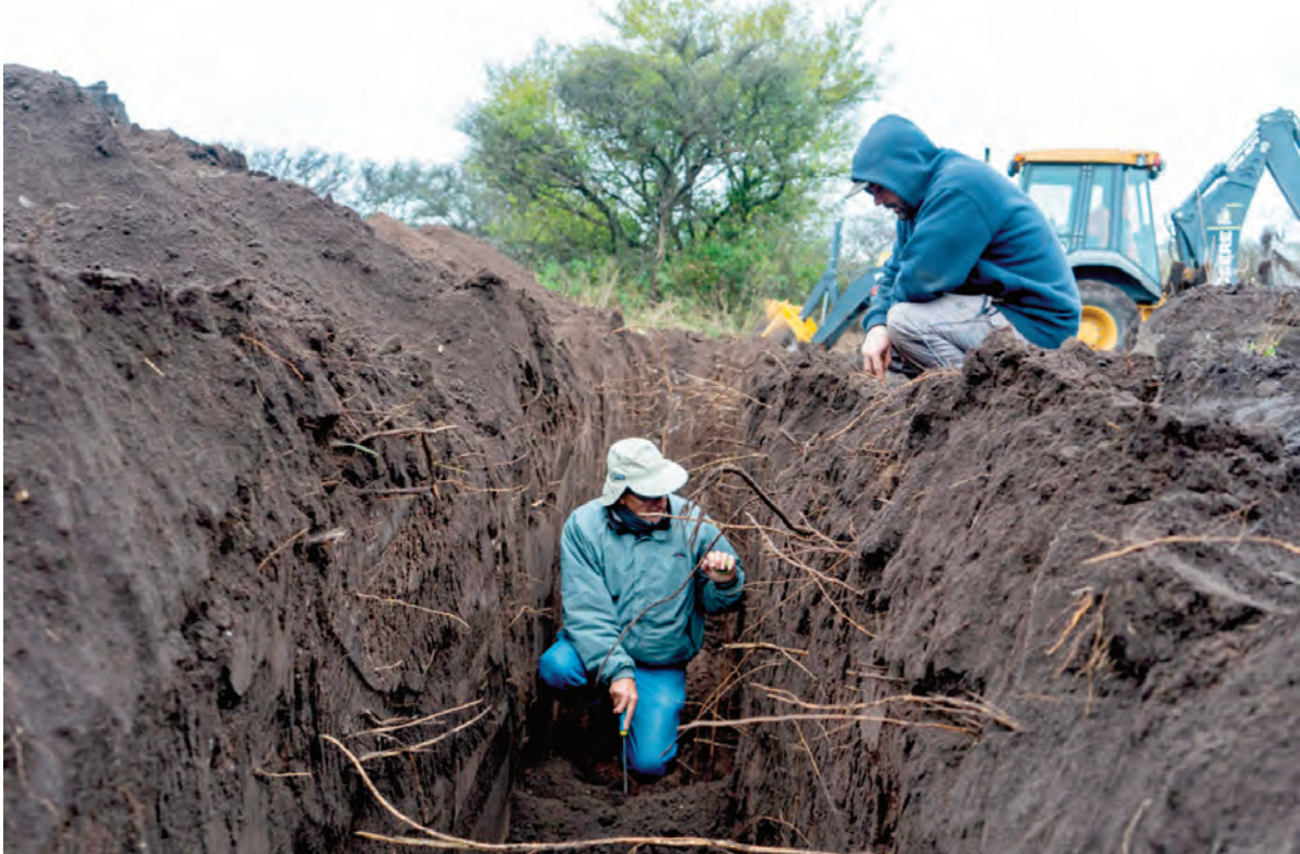
Excavaciones en La Perla.
