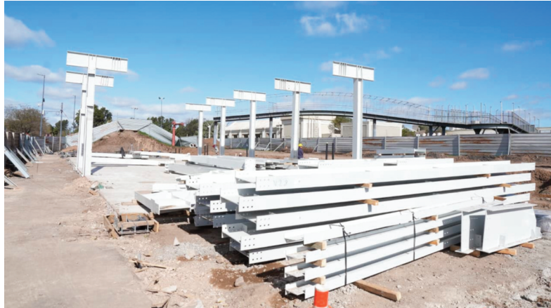
Así está la obra del edificio “Fórum”, que tendrá un innovador jardín horizontal en la terraza.
