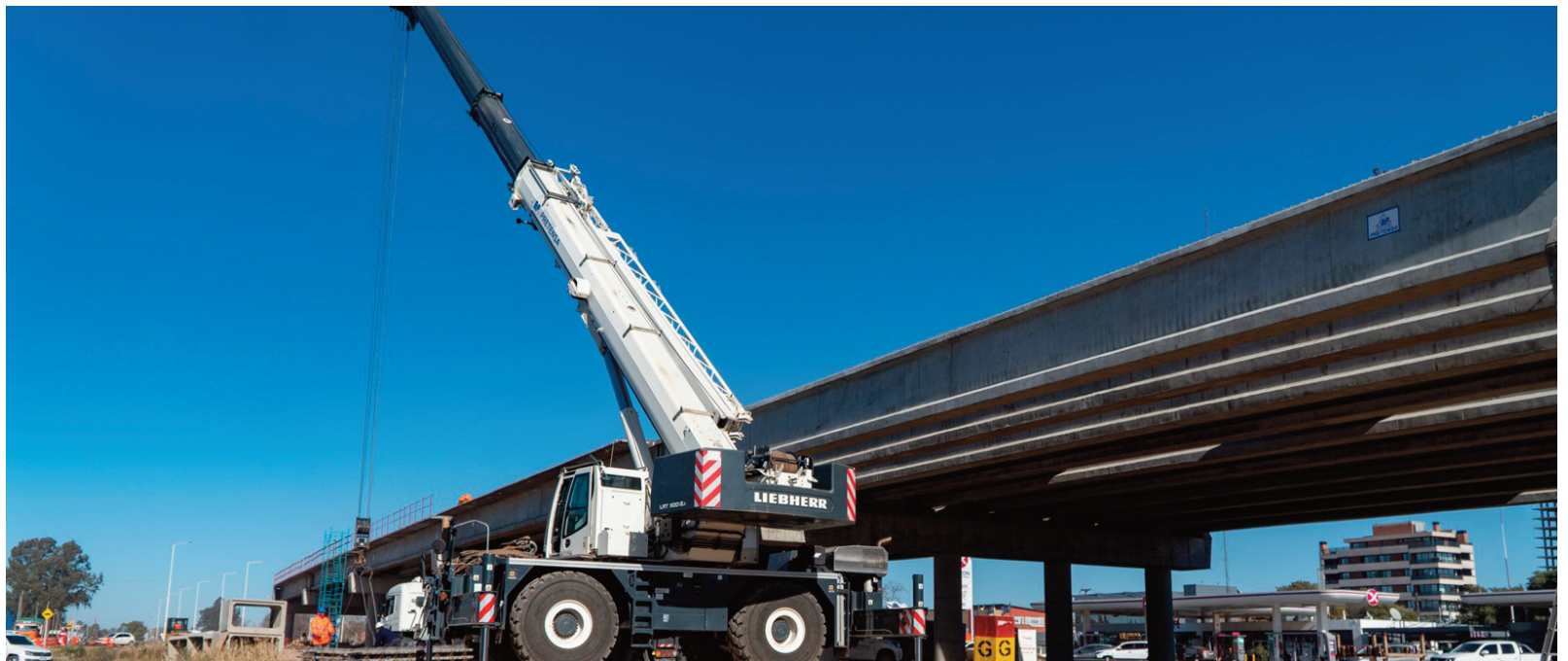
Construyen uno de los altos niveles de la Circunvalación.
