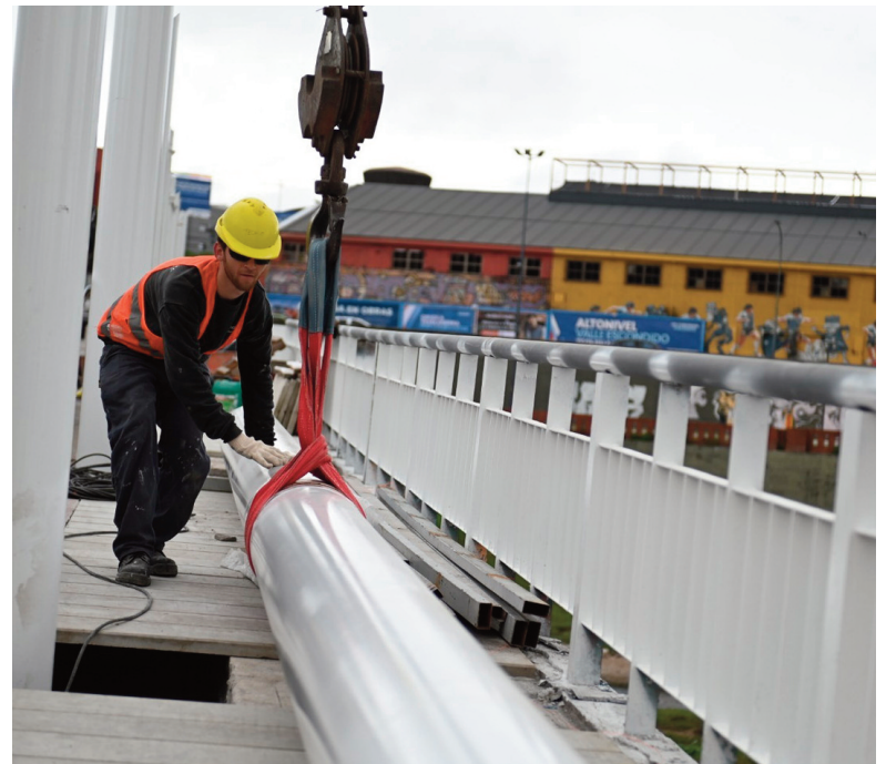
Uno de los principales avances se registra sobre la Costanera Norte.
