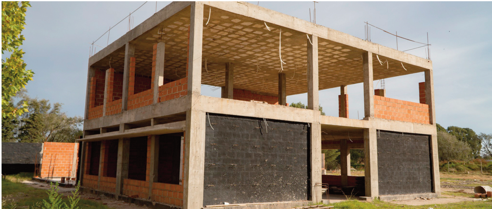
La obra del nuevo edificio está parada.
