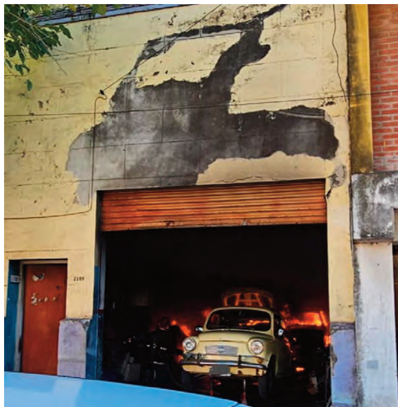
Se investigan las causas que derivaron en el incendio del taller.
