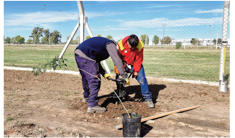
El avance en obras y en la forestación del nuevo predio de San Lorenzo y Deportivo Las Playas.
