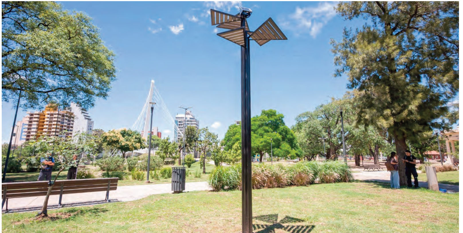
El árbol solar instalado en el Parque Las Heras-Elisa.
