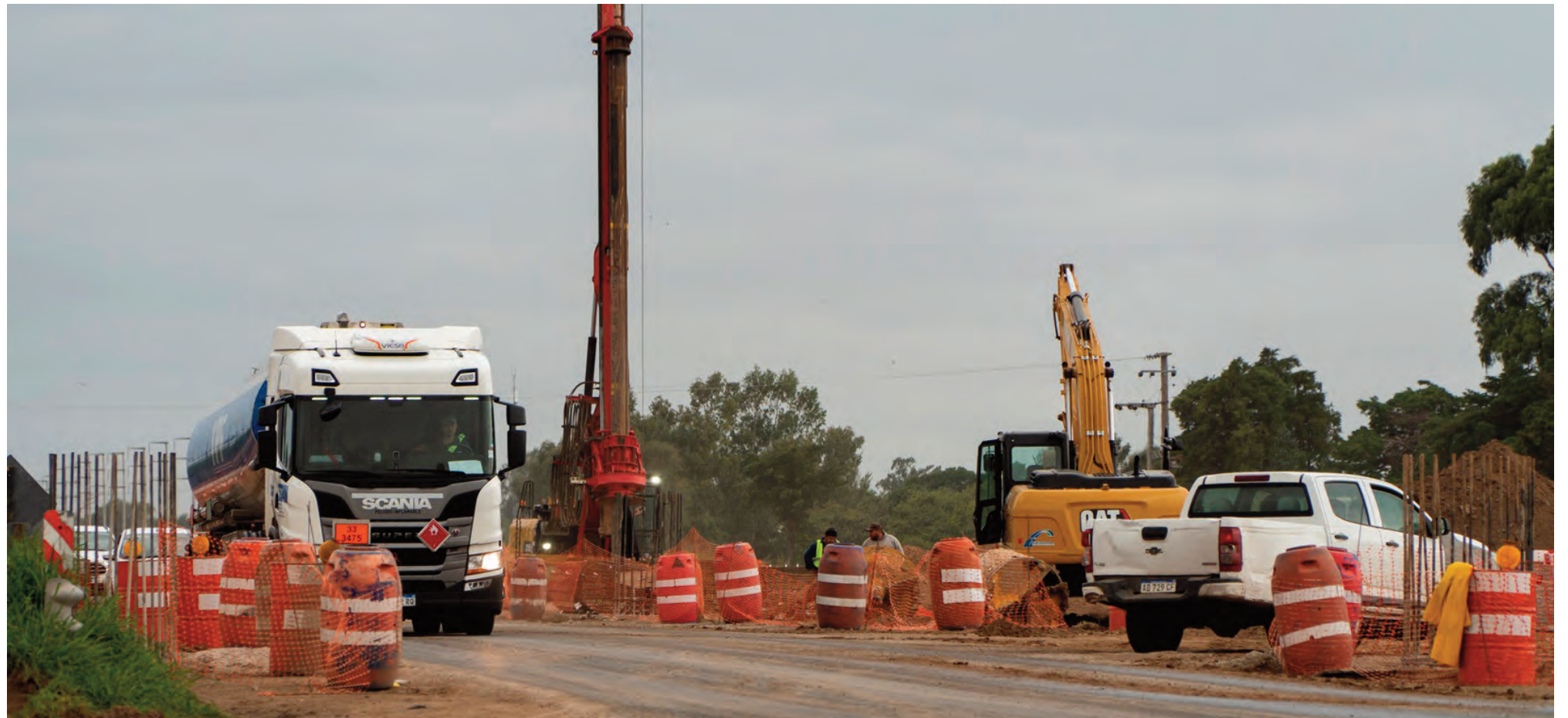
Se intensifican los trabajos sobre la ruta 8.
