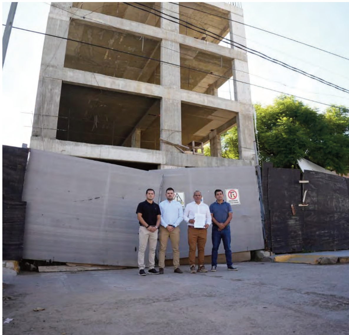
El proyecto original contempla la construcción de 10 pisos con 80 departamentos, aunque actualmente hay cuatro niveles levantados.
