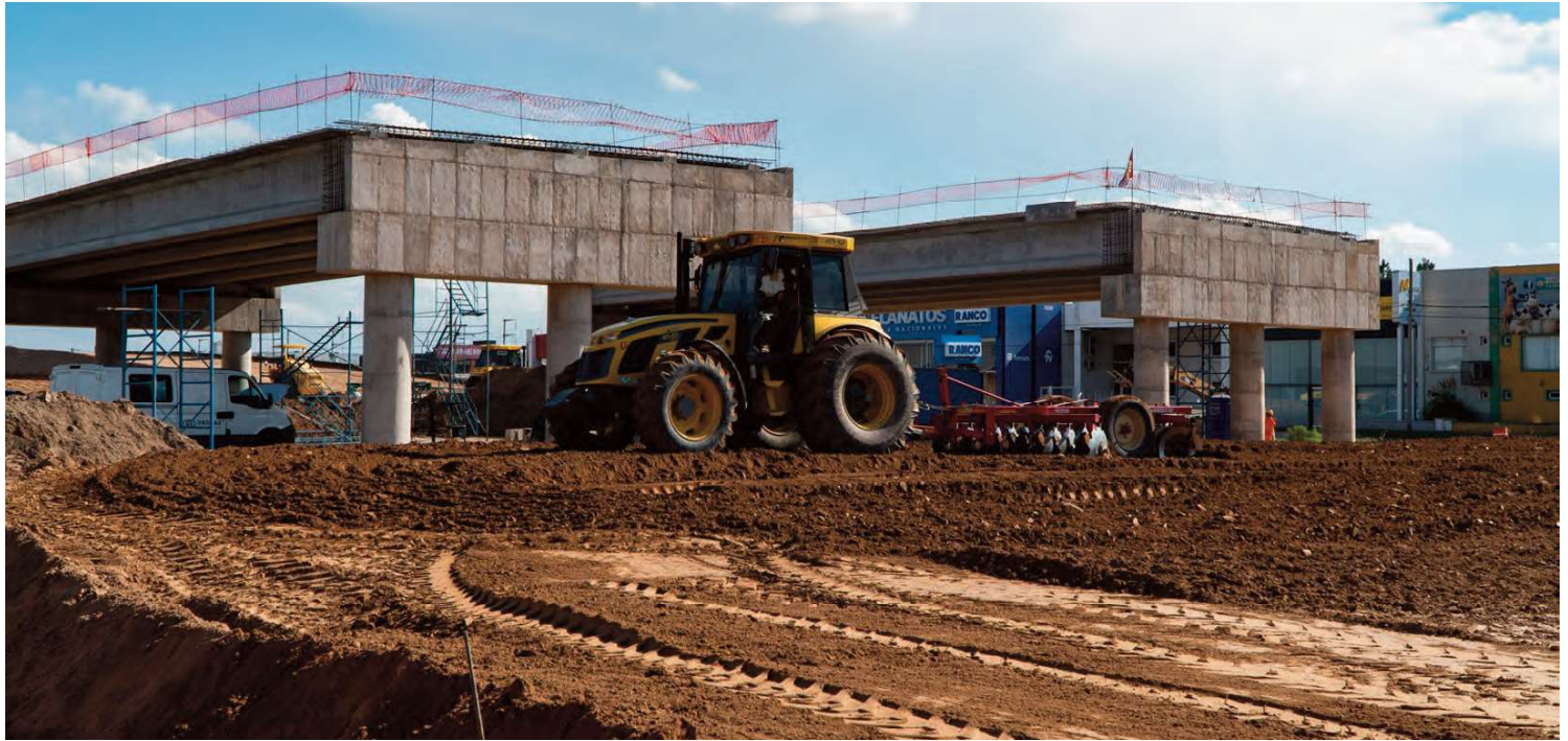
Avanza la obra del nuevo anillo vial de la ciudad.
