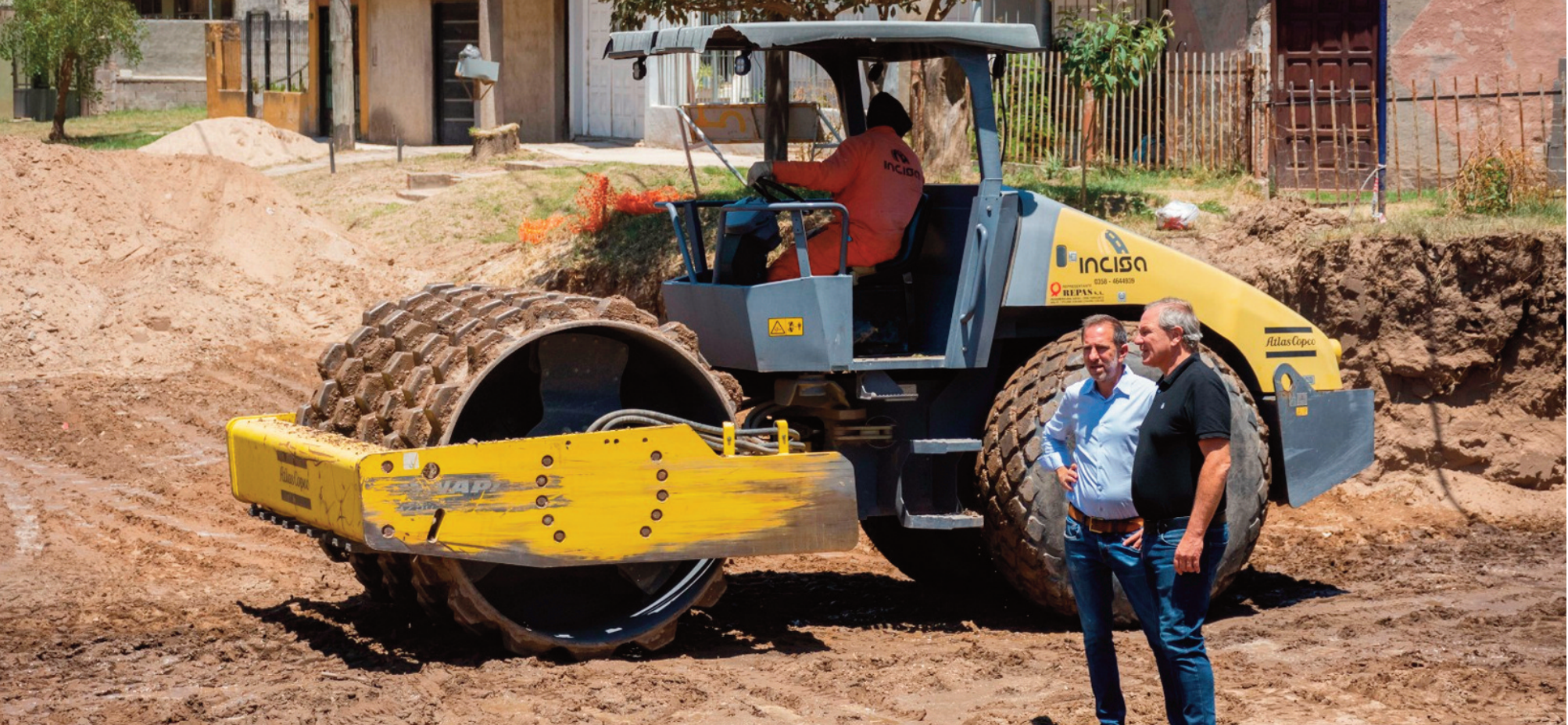
El intendente recorre las obras de pavimento.
