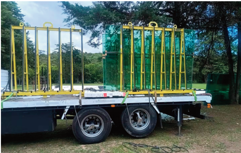
Las placas de vidrios templados para la construcción de una cancha de pádel.
