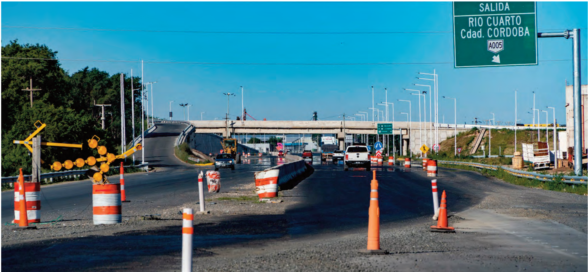
La doble vía estará habilitada en dos semanas, se informó.
