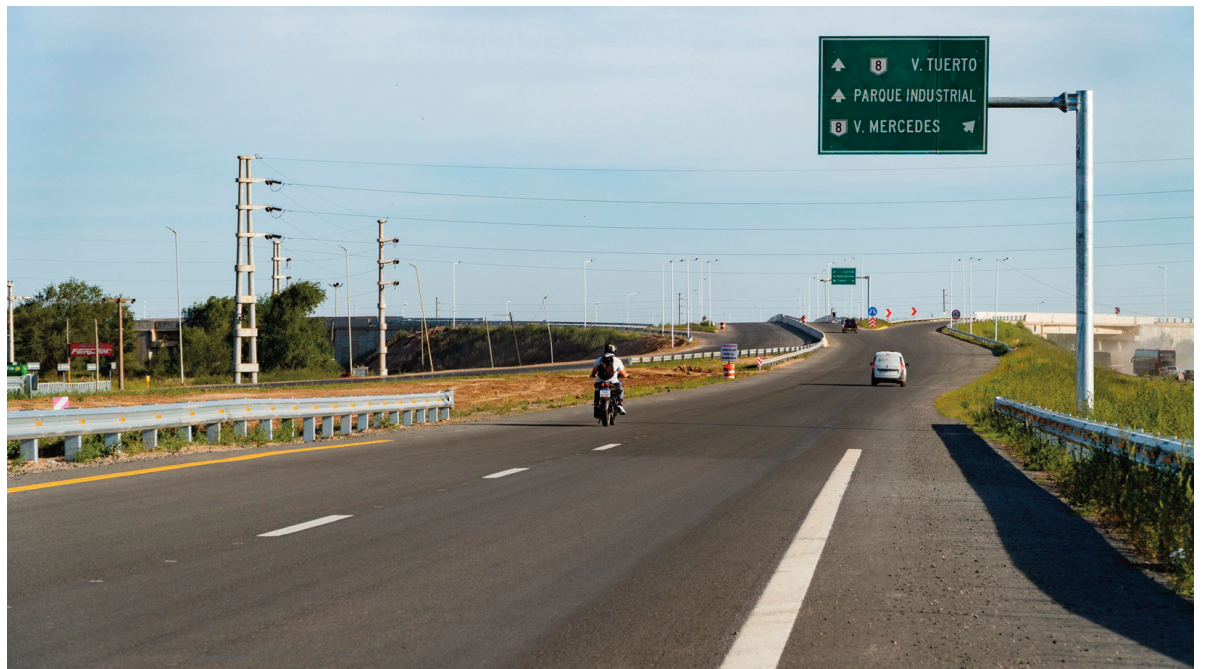
El primer tramo de la Circunvalación quedó concluido.
