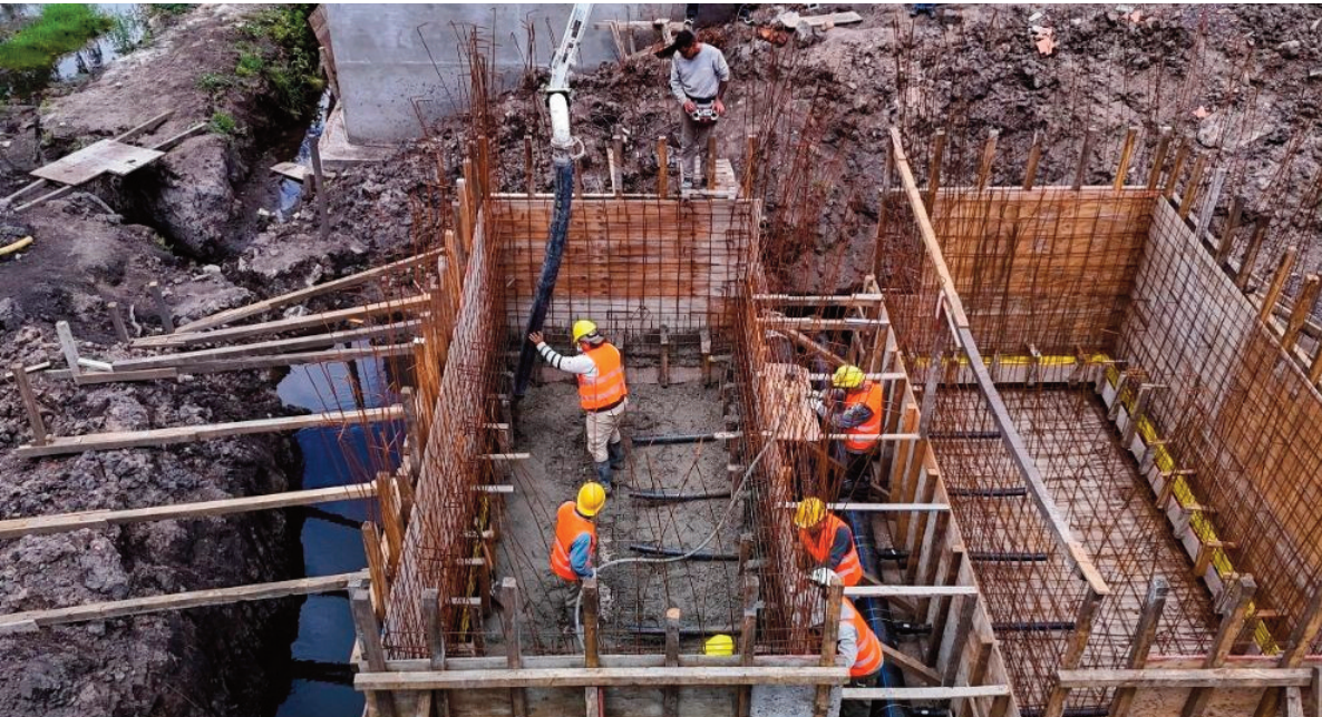
La obra de la nueva planta ya superó la mitad de su desarrollo.
