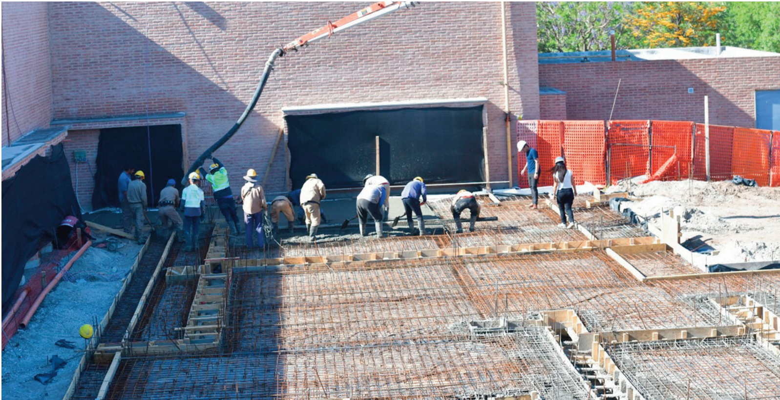
Las obras de ampliación ya están en marcha.
