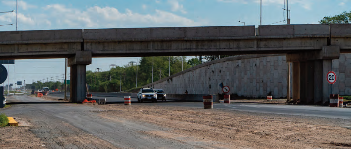
Aseguran que en noviembre estará lista la autovía.
