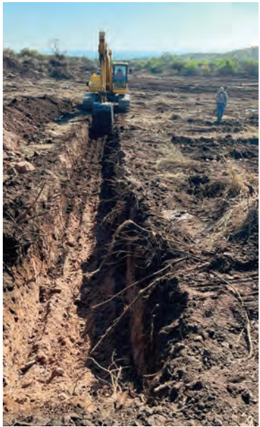
El trabajo de excavación.
