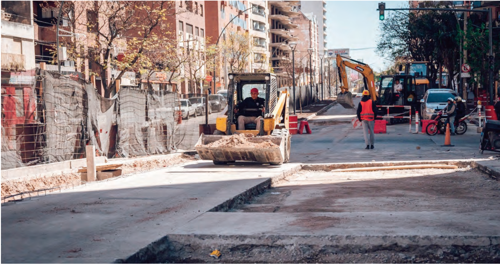
La intervención en el Bulevar San Juan apunta a recuperar el espacio público y a mejorar la convivencia entre vehículos y peatones.
