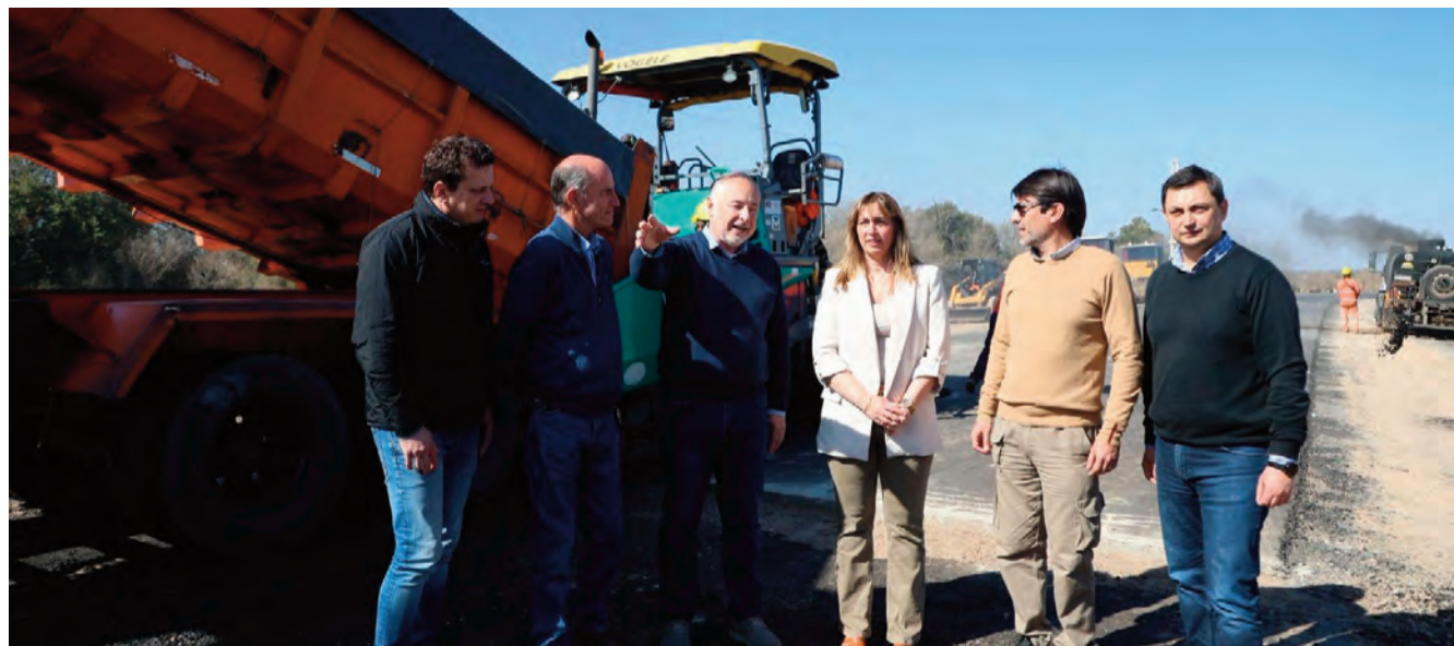
Accastello recorrió la obra del arco Sudeste de la Circunvalación Villa María - Villa Nueva.
