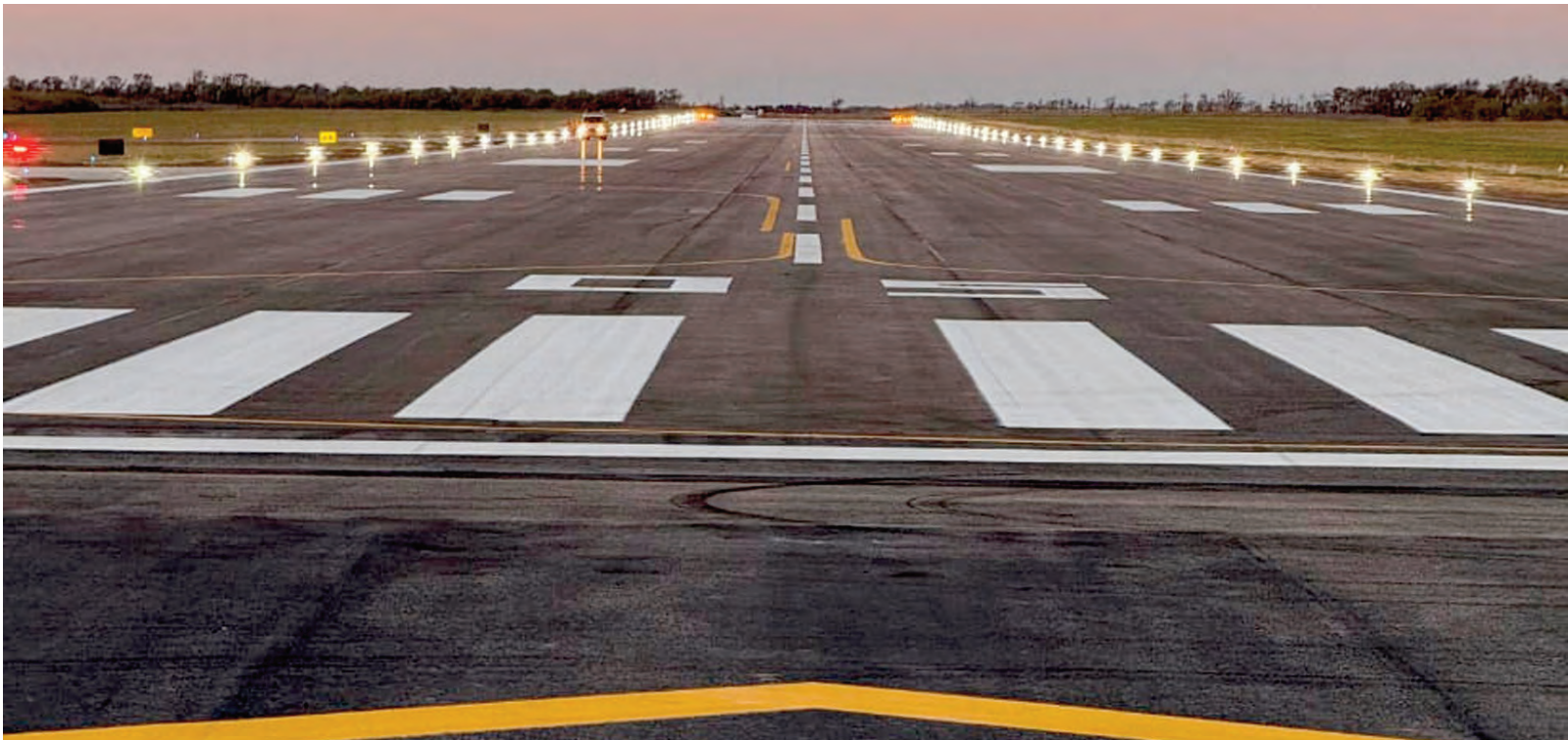
La pista finalizada.
