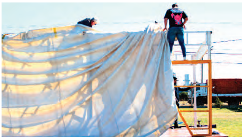
Las estructuras empezaron a quedar listas para armar las carpas en el predio.
