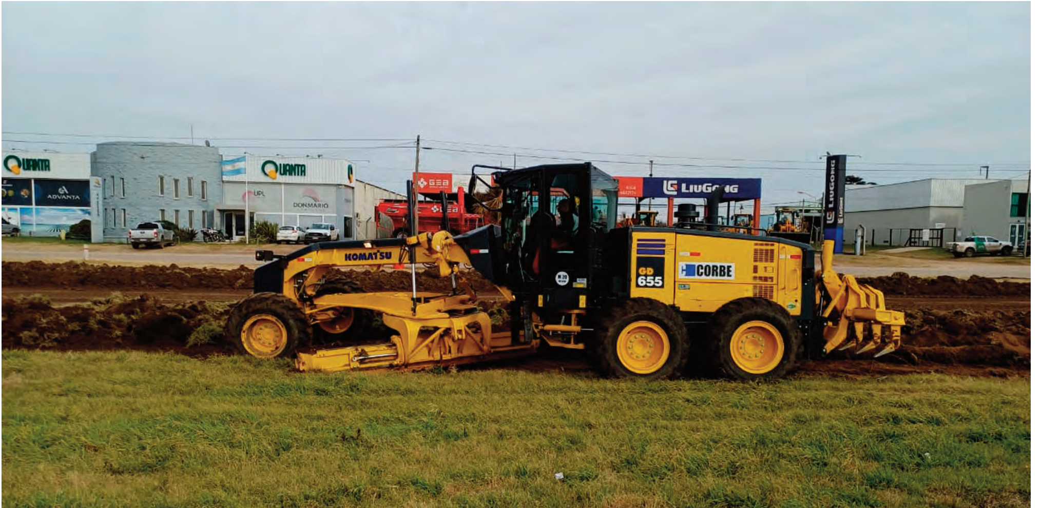
Comenzaron los trabajos en un nuevo tramo de la Circunvalación.
