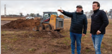
El intendente Accastello supervisó ayer las obras junto al secretario Fuyana.
