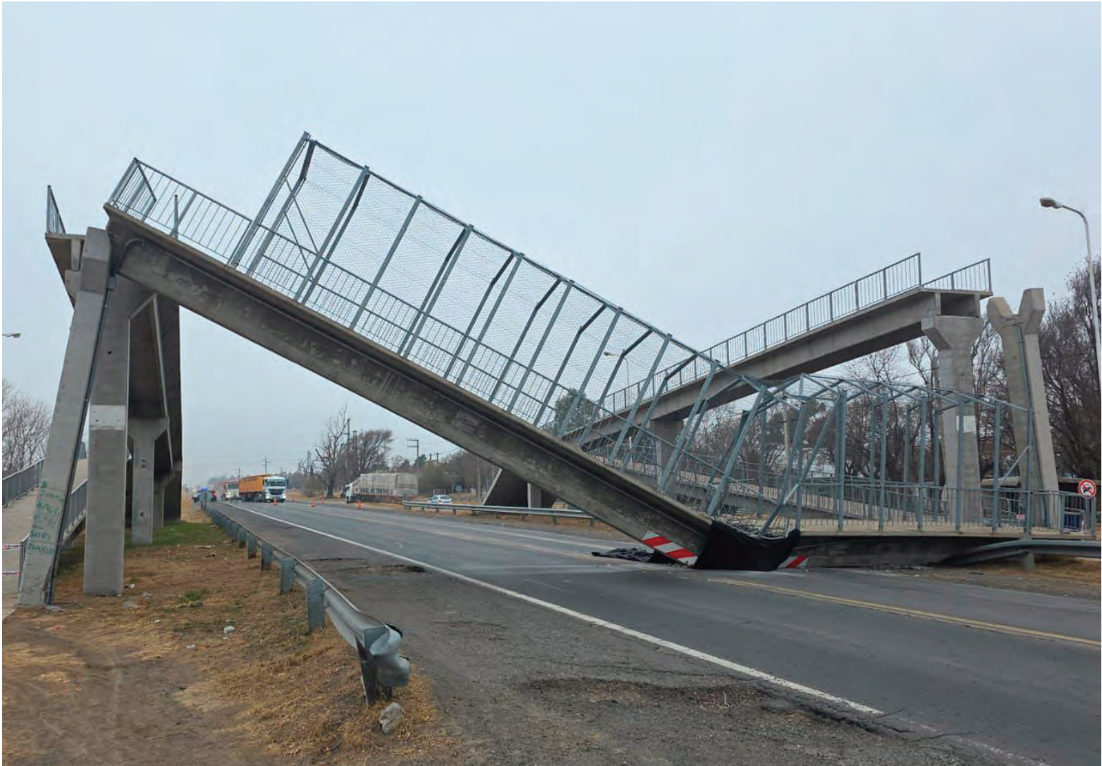
El puente peatonal cayó sobre la ruta 7 el lunes y allí permanece, cortando el tránsito en la zona. La Provincia pide que la Nación dé una solución.
