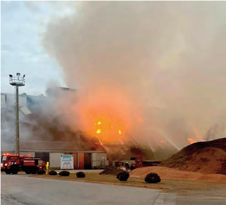
La planta produce 10 megavatios de electricidad; equivalente al consumo de la ciudad.
