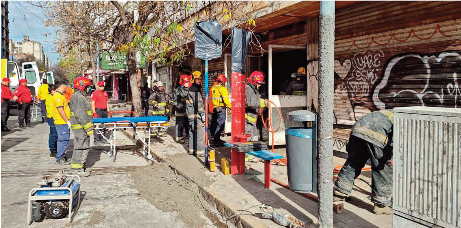
El galpón estaba en construcción en la avenida General Paz.
