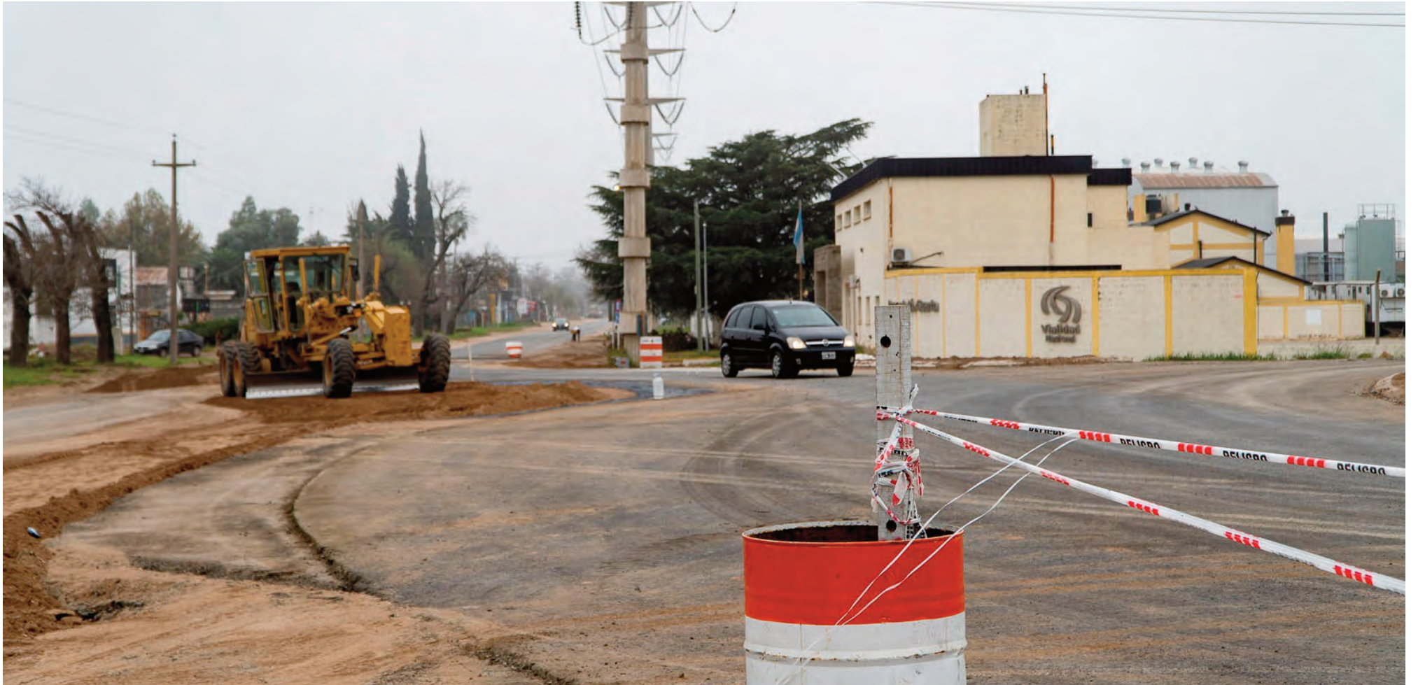
Siguen los trabajos en la Circunvalación.
