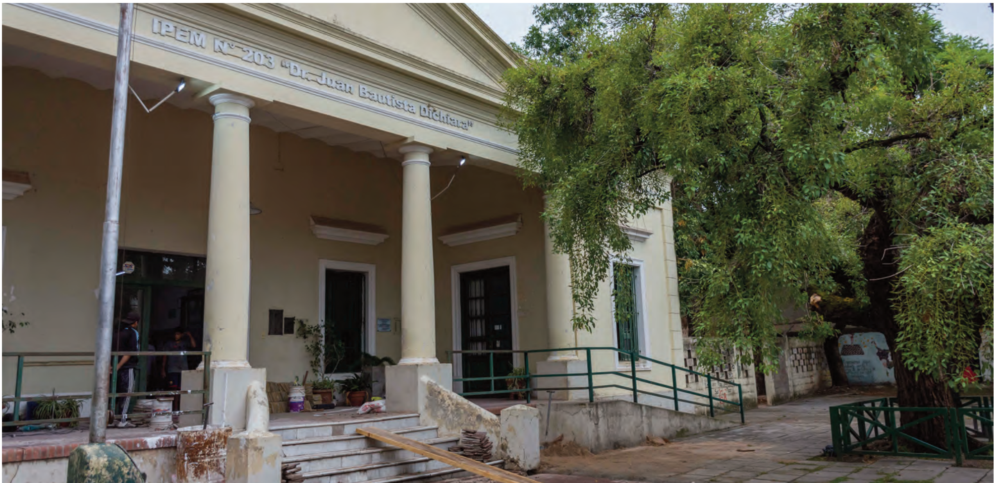
El edificio donde funciona el Ipem N° 203 "Doctor Juan Bautista Dichiara" data de 1887, tiene 138 años de antigüedad.
