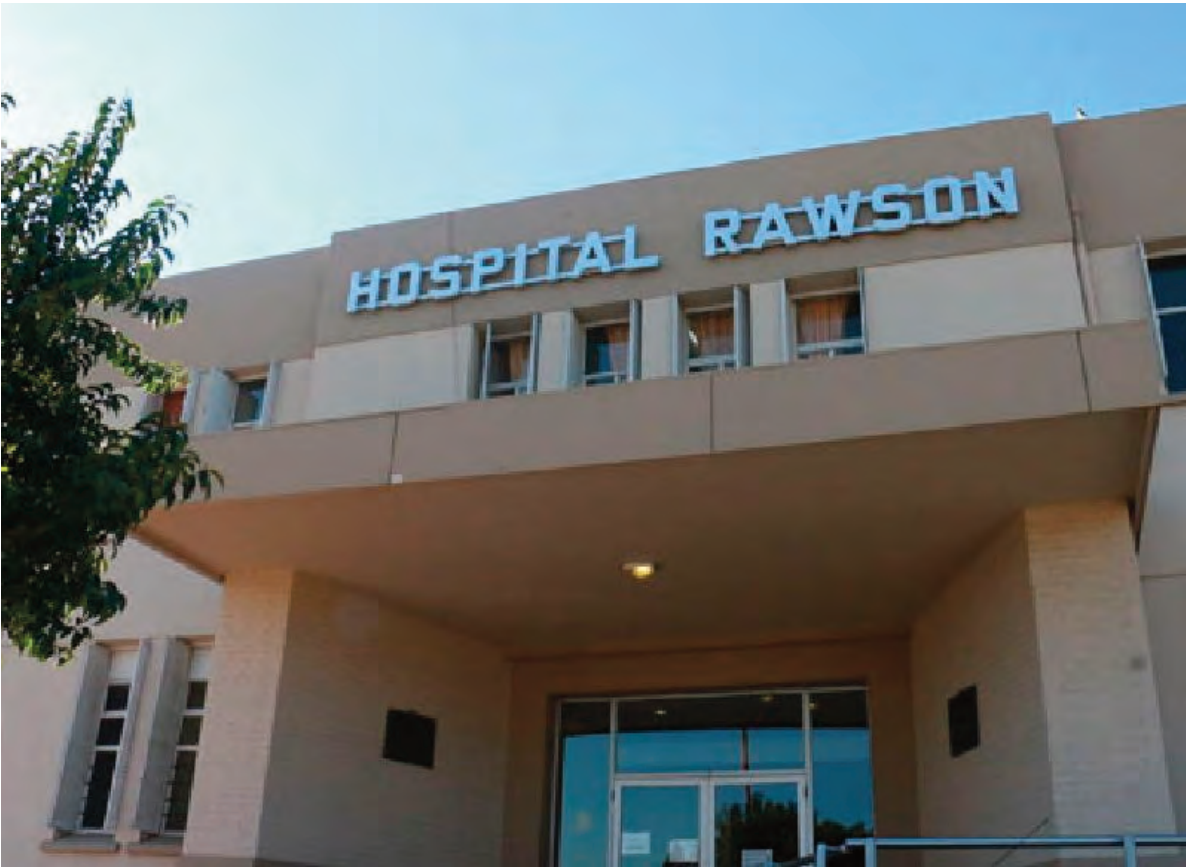
El hospital Rawson ubicado en el llamado Polo Sanitario de Córdoba.
