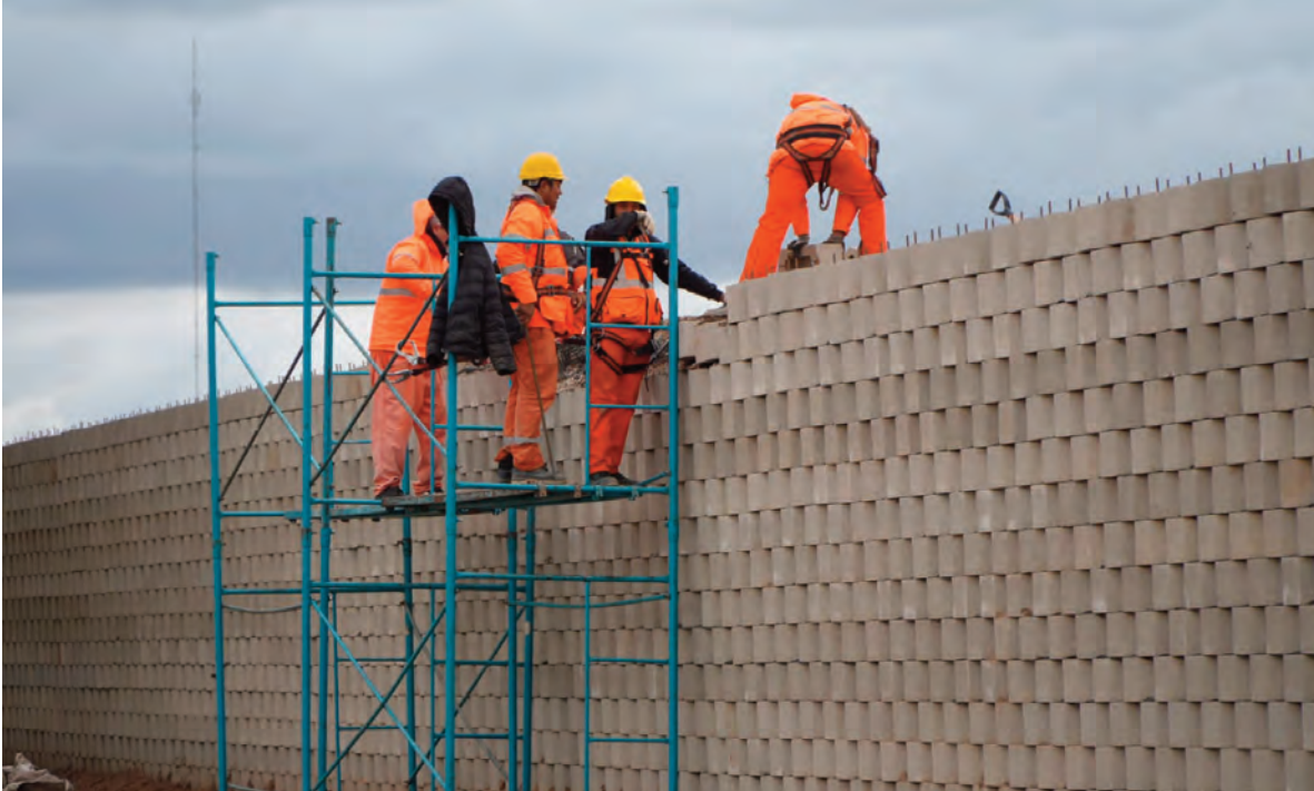
Avanza la obra de la Circunvalación.
