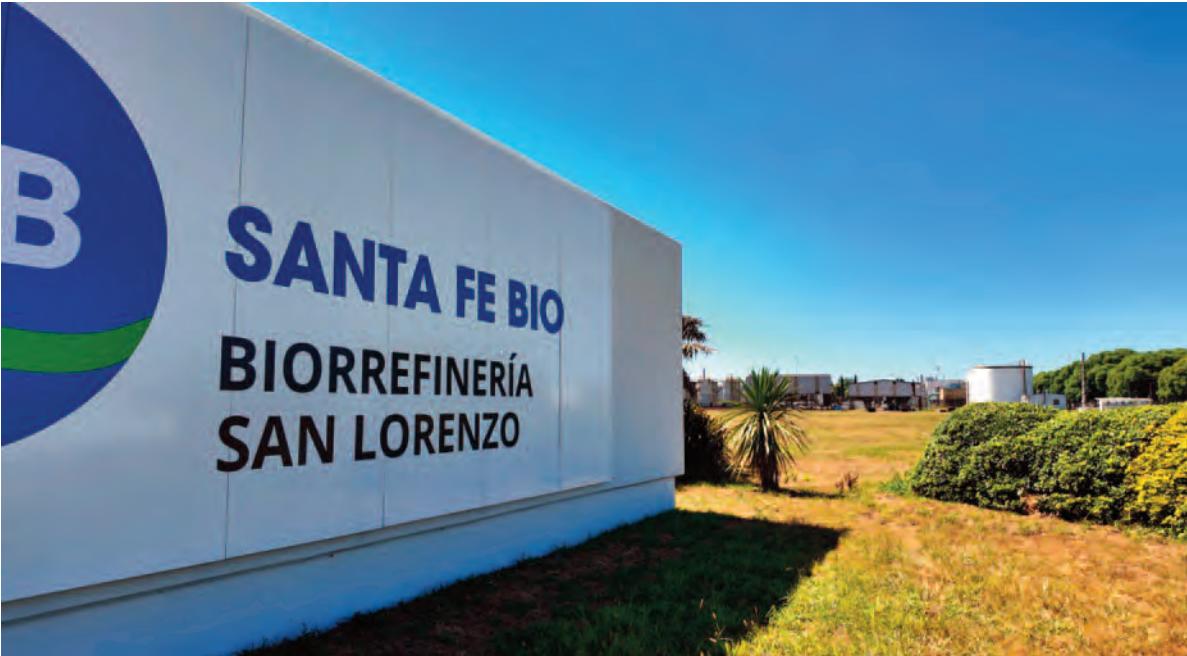
La planta en Santa Fe, sobre la hidrovía, donde se construirá la infraestructura necesaria para la producción del biocombustible.
