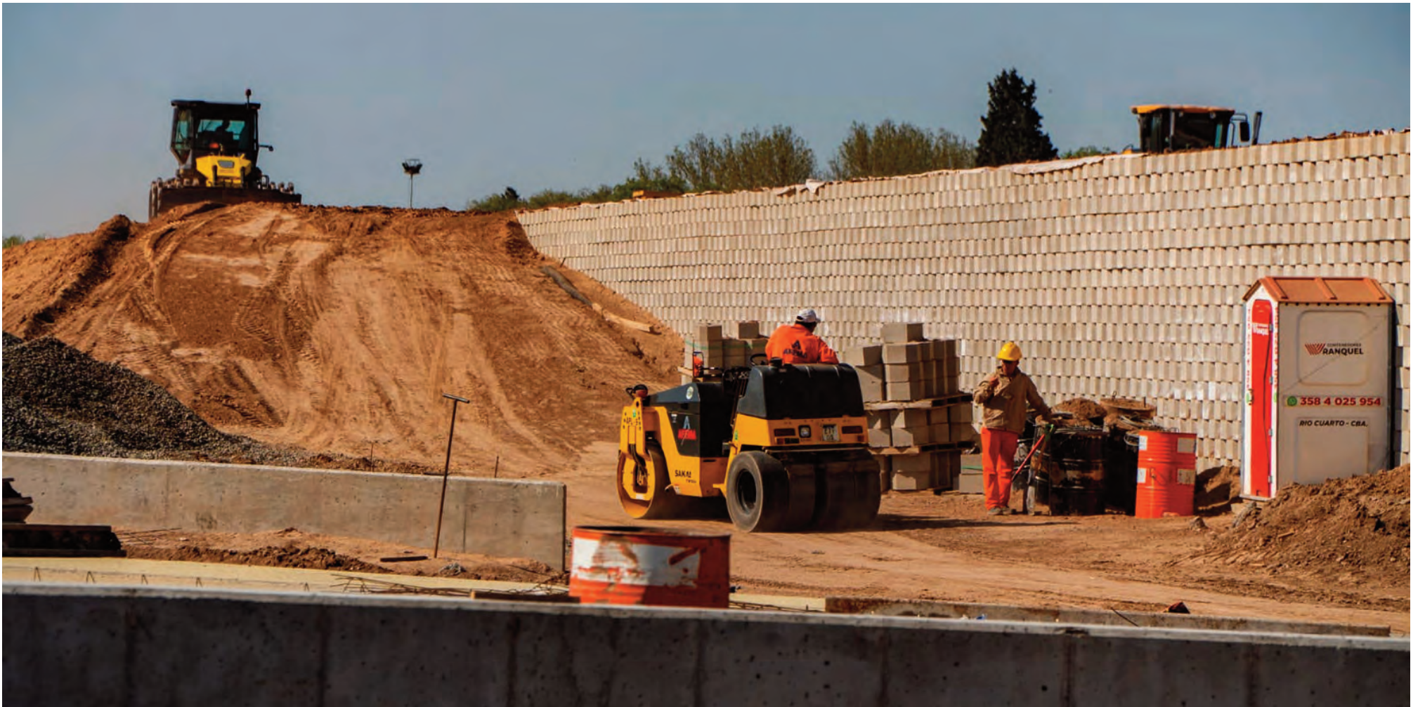
Avanza la megaobra de la Circunvalación.
