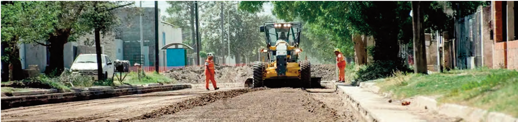
La obra de repavimentación de cuadras comenzará en noviembre.
