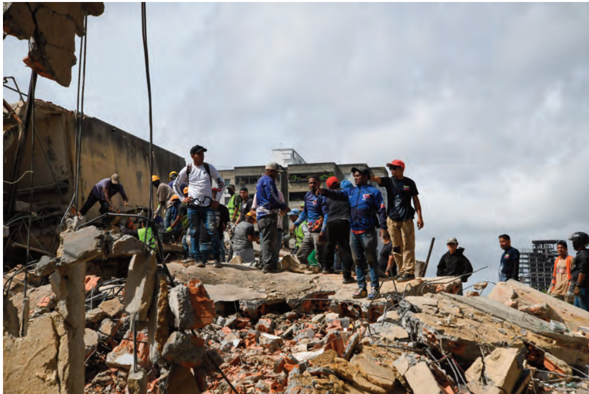
Rescatistas buscan señales de vida entre los escombros que quedaron de un edificio en Caracas.
