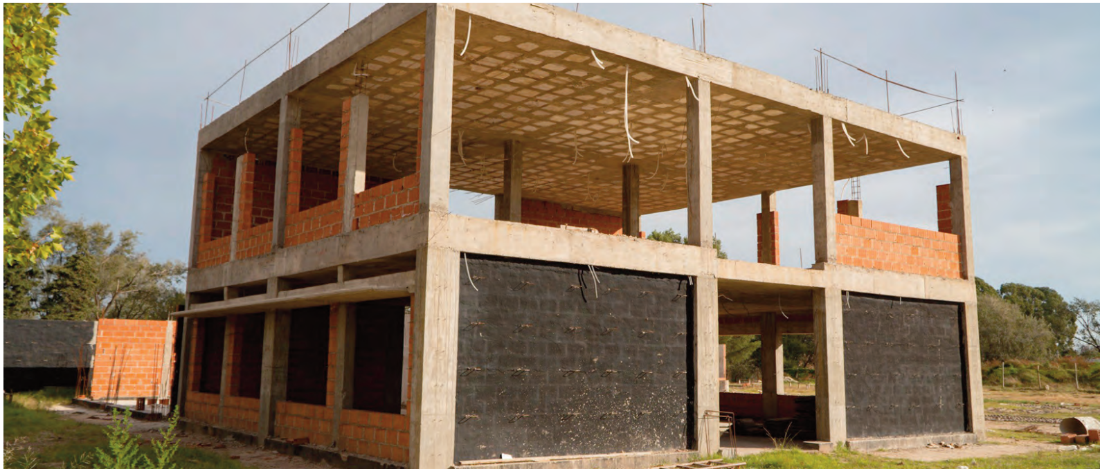
La obra del nuevo edificio está parada.
