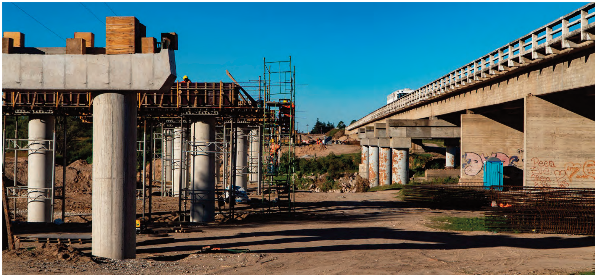
Comenzó la duplicación del puente Antártida.
