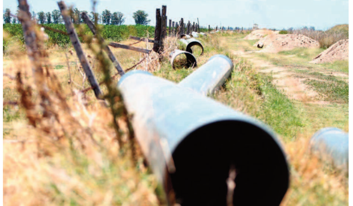
En noviembre de 2022 los caños iban colocándose al costado de los alambrados para luego realizar la excavación para el acueducto.
