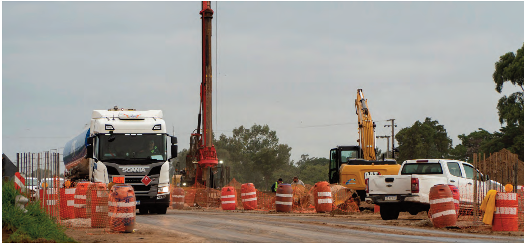
Se intensifican los trabajos sobre la ruta 8.
