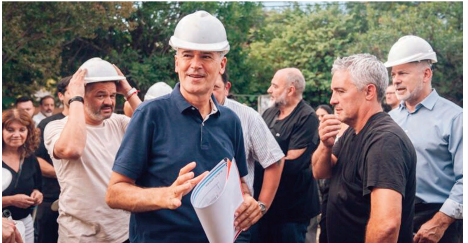
El intendente Passerini estuvo en el inicio de las obras.
