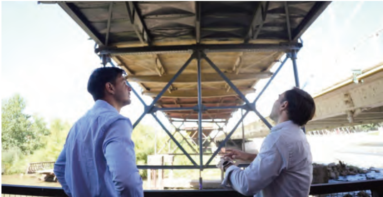
La obra tiene un plazo estimado de ejecución de 270 días si el clima lo permite.
