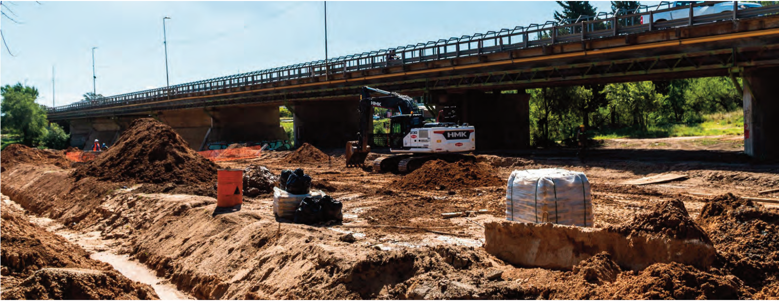
Remueven cañerías de agua por la obra de la Circunvalación.
