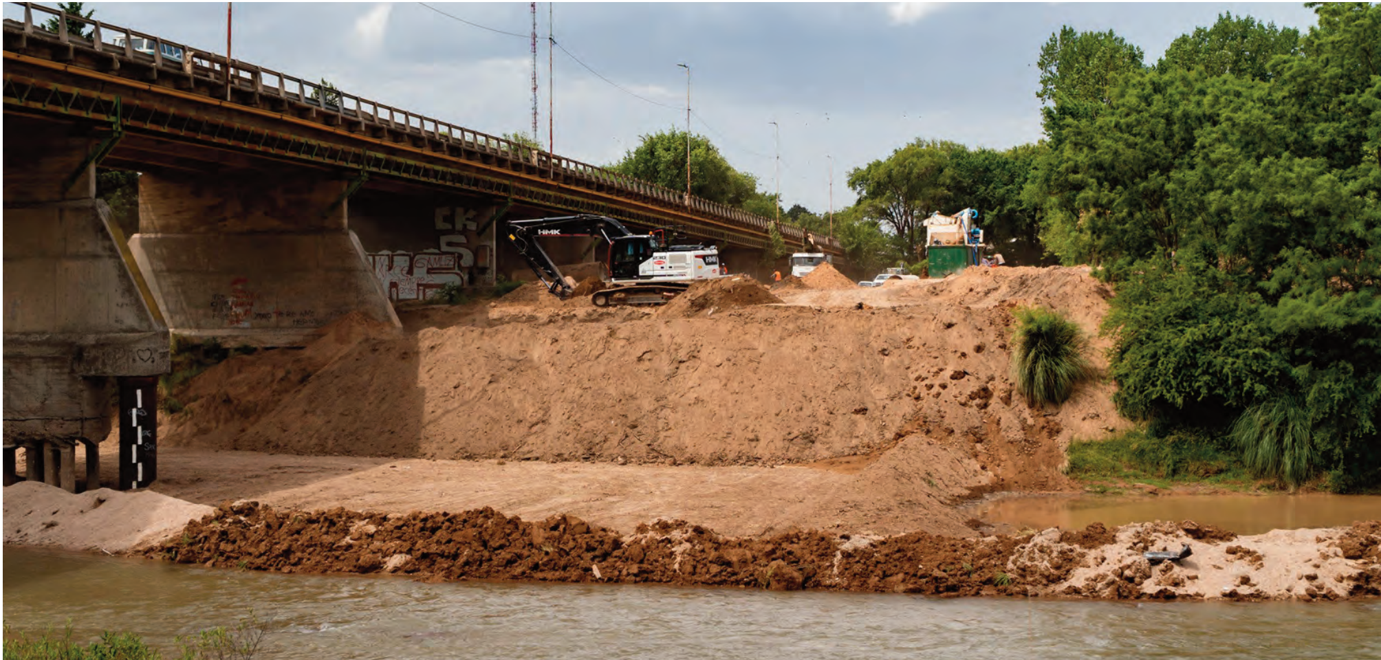
Arrancaron los trabajos de duplicación del puente Malvinas.
