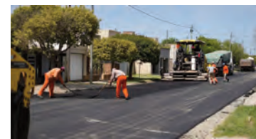
Las obras en el Nicolás Avellaneda.
