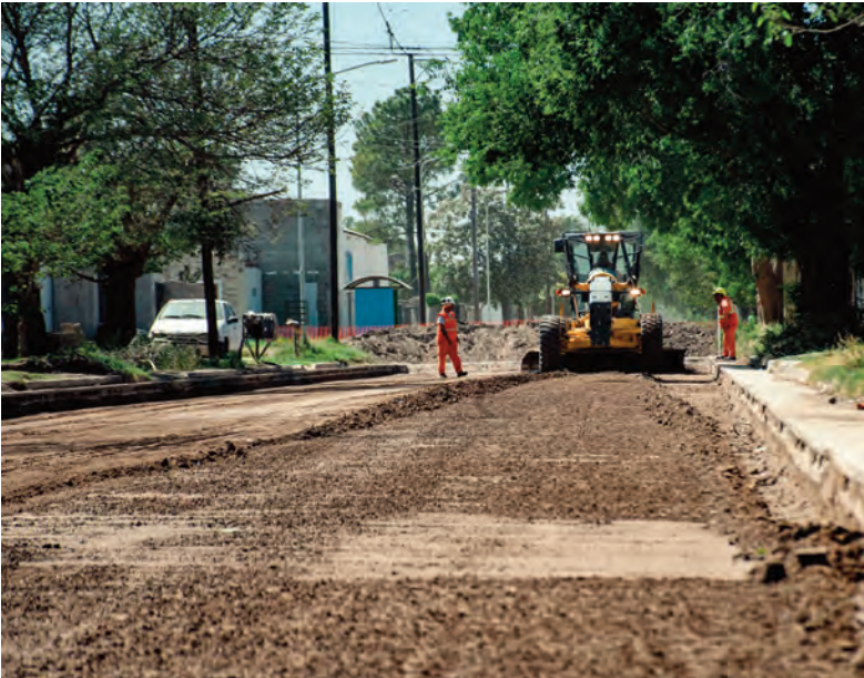
El comienzo de las obras de pavimentación sobre calle Entre Ríos.
