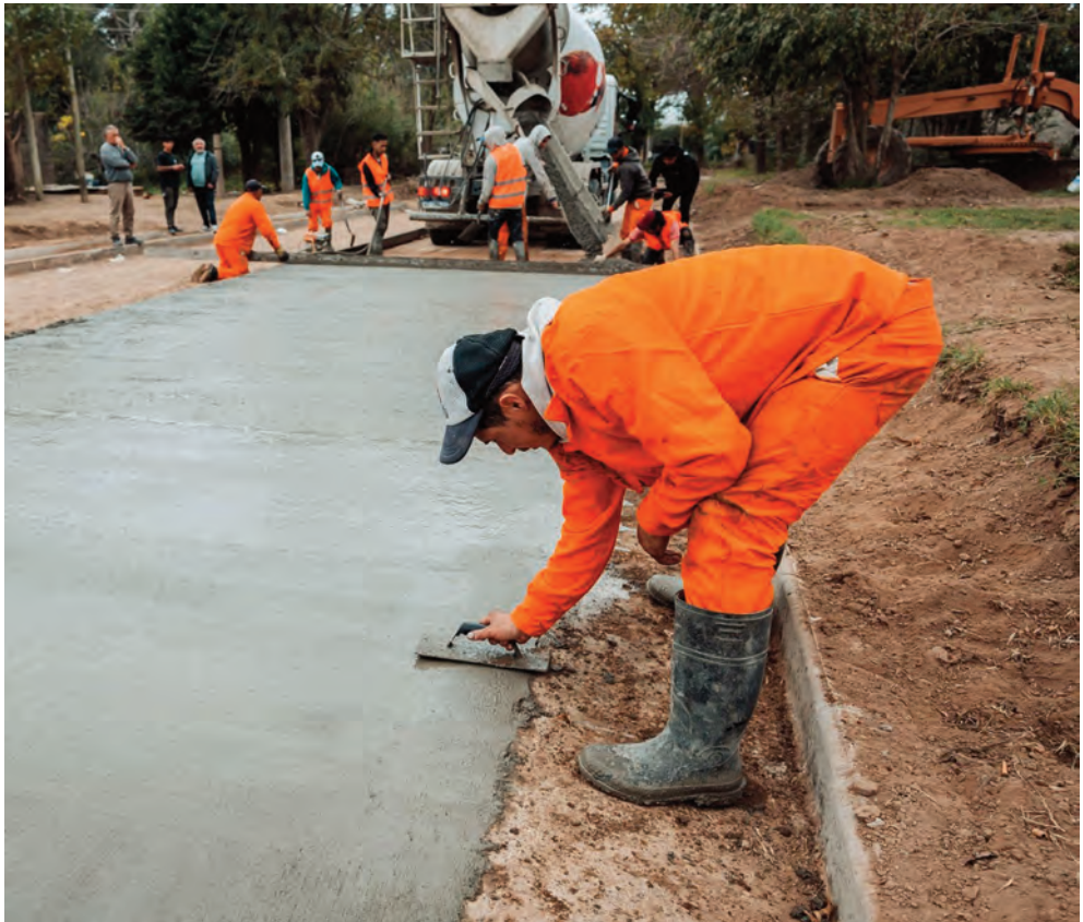
Las obras de asfalto se extienden por 13 frentes en simultáneo.
