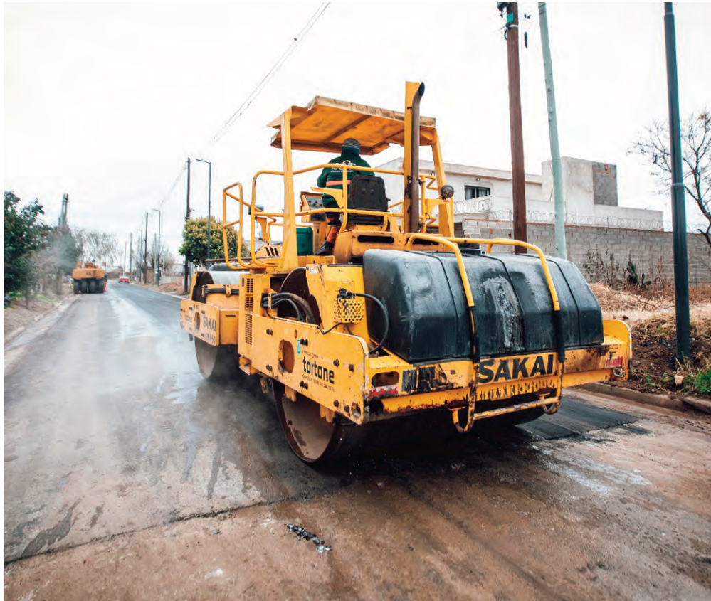
Las máquinas no detienen su marcha en los 30 barrios que reciben obras.
