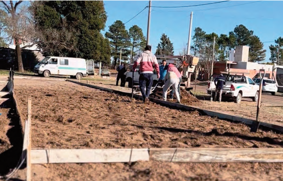
La construcción está a cargo de trabajadores de Alcira seleccionados a través de un concurso de precios.
