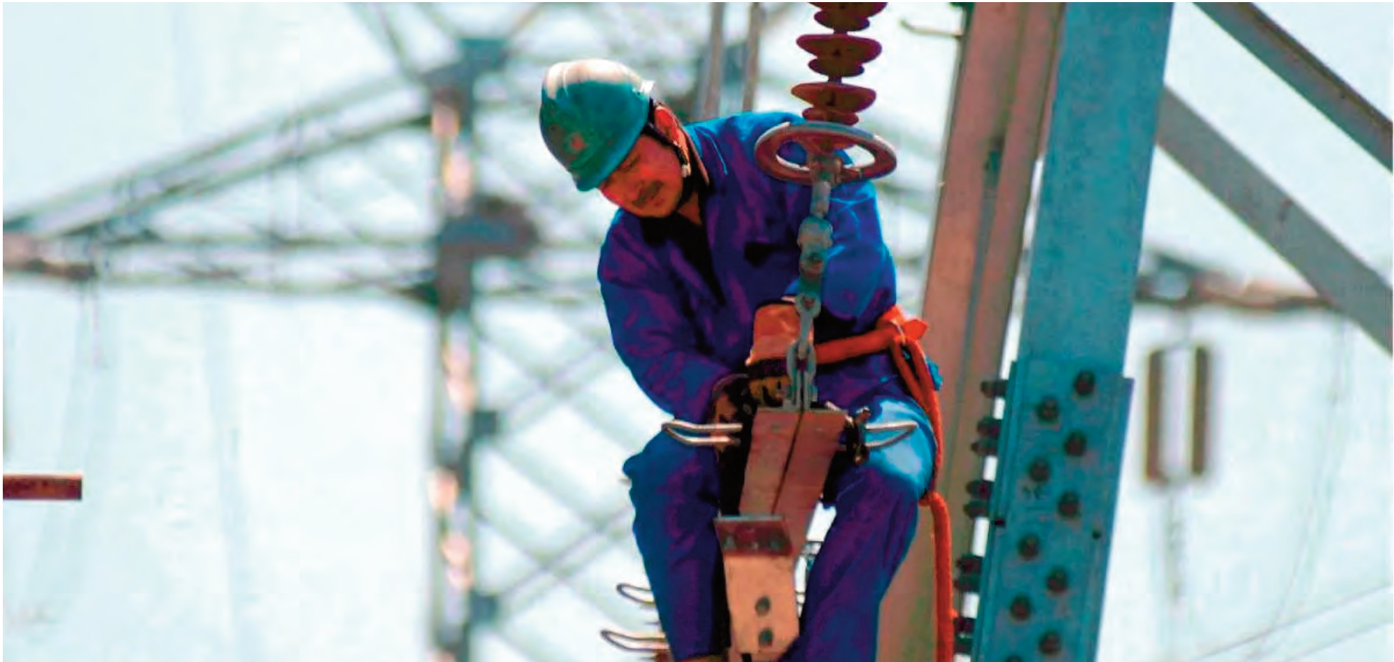
El sistema eléctrico fue tensionado por la demanda durante el mes de junio, con temperaturas por debajo de los datos históricos.
